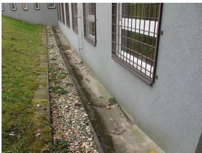
Foto č. 15 – způsob provedení záchytných systémů (odvodňovací žlab s drenáží) ze strany severního svahu
