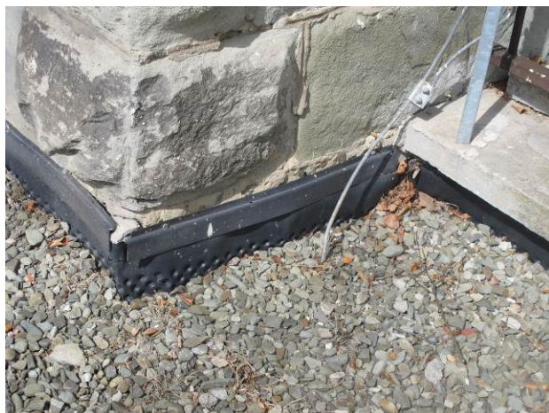
Foto č. 4 – detail úpravy nopovou fólií s ukončovací lištou a štěrkem z lomového kameniva
