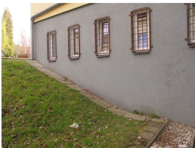
Foto č. 17 – okapový chodník bez odspádování a mezerami v návaznosti na místnost se sprchami
