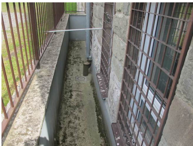
Foto č. 11 – způsob provedení anglického dvorku v návaznosti na prostory dílen, degradace kamenného soklu ve vysoké úrovni
