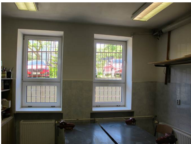
Foto č. 37 – keramické obklady v dílně do úrovně původní výšky vlhkostní mapy
