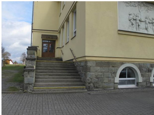
Foto č. 2 – nekryté boční přístupové schodiště s netěsností spár mezi prvky schodiště a zdivem
