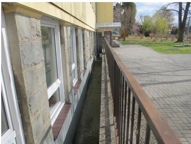
Foto č. 5 – anglický dvorek podél jídelny a kuchyně s odvodňovacími vpustěmi
