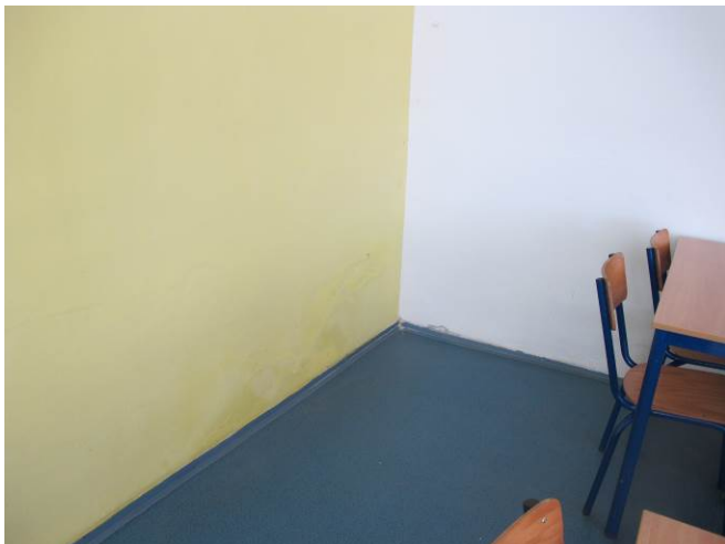
Foto č. 31 – vlhkosti na předělovací stěně mezi jídelnou a skladem (hlavní uzávěr vody)
