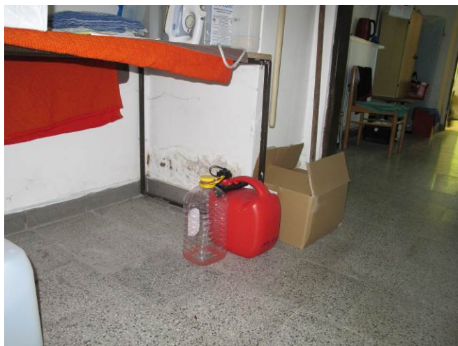
Foto č. 39 – vztlínající zemní vlhkost ve zdivu a výskyt plísní v úklidovém prostoru
