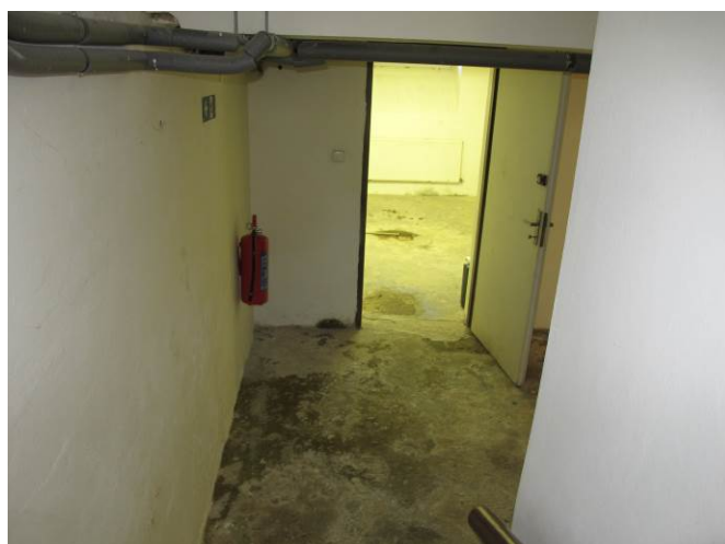
Foto č. 8 – podlahy suterénu s kondenzací vodních par na povrchu
