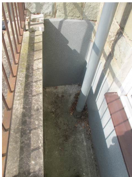
Foto č. 6 – detail povrchové úpravy stěn anglického dvorku marmolitem s betonovým dnem a zaústěným dešťovým svodem
