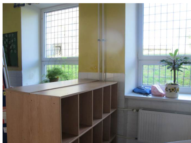
Foto č. 28 – výstup vlhkosti nad obklady na pilířích mezi okny
