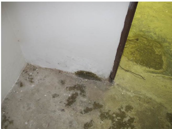
Foto č. 9 – výskyt plísní ve spodních úrovních nad podlahou
