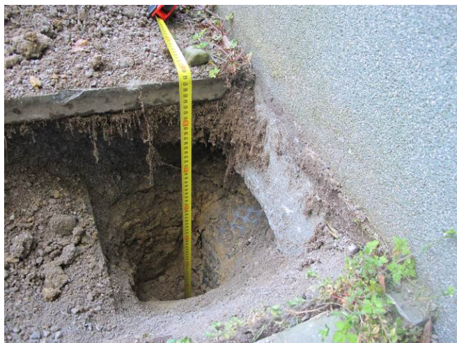
Foto č. 21 – detail provedené kopané sondy ze severní strany
