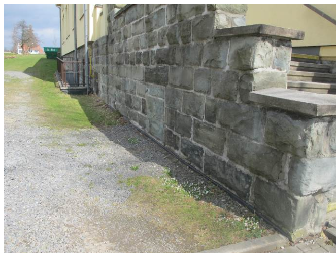
Foto č. 10 – vadně vyspádovaný terén způsobující dotaci vlhkosti do zdiva
