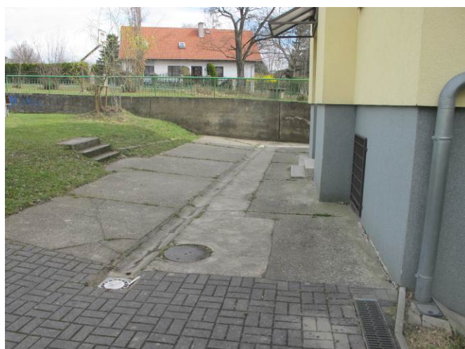
Foto č. 18 – způsob provedení zpevněných ploch a jejich odvodnění s vchodem do 1.NP
