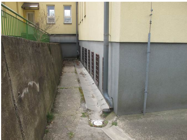
Foto č. 19 – způsob provedení zpevněných ploch a jejich závadovým odvodněním v návaznosti na prostor šaten
