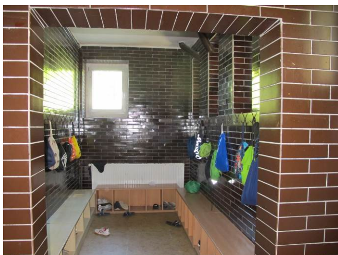
Foto č. 25 – celoplošný keramický obklad z pásků u šaten jižní strany
