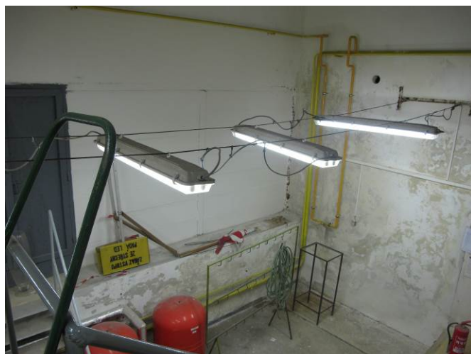
Foto č. 34 – destrukce omítek v kotelně
