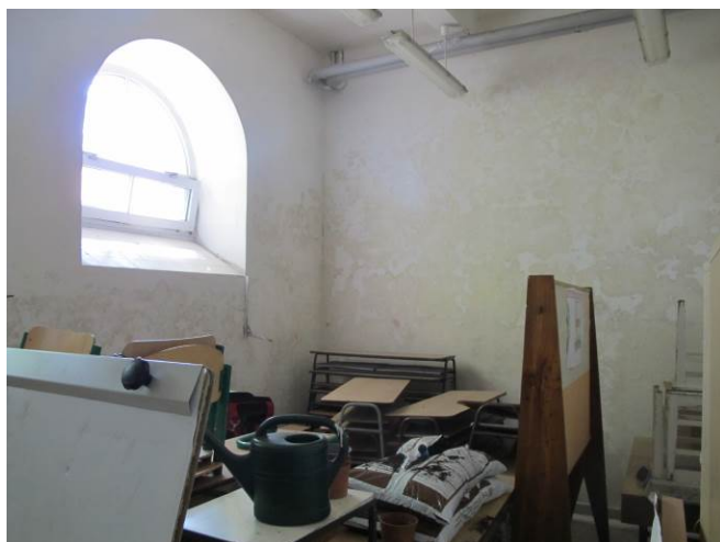
Foto č. 33 – degradace omítek v prostoru skladu (hlavní uzávěr vody)
