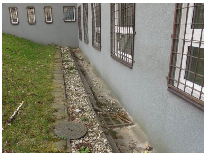
Foto č. 16 – detail provedení odvodňovací vpusti
