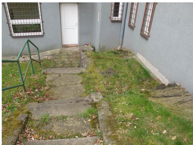
Foto č. 14 – nedořešená zemní úprava povrchů v návaznosti na úklidovou šatnu a zadního vstupu s podestou
