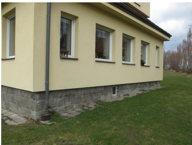
Foto č. 3 – vadné provedení okapového chodníku s propadlou dlažbou z východní strany
