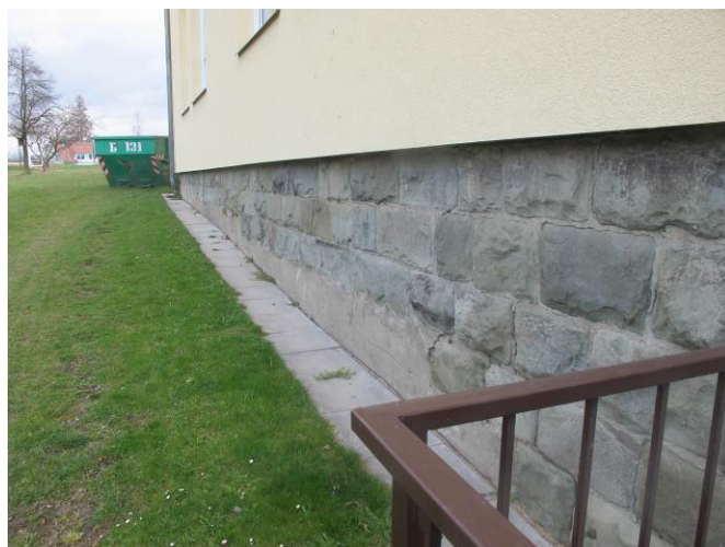
Foto č. 12 – oprava betonovou vysprávkou kamenného soklu nepodsklepené tělocvičny
