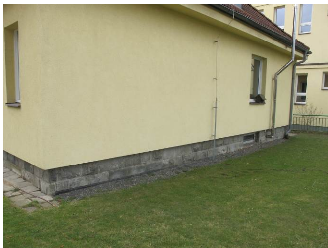
Foto č. 4 – neúčinná štěrková úprava ze severní strany
