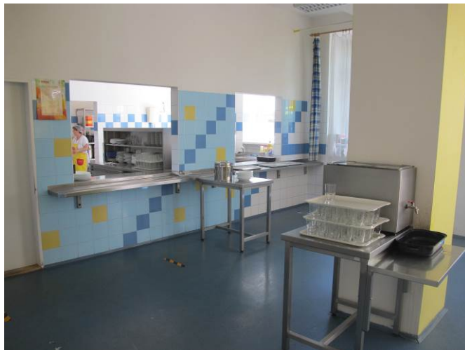
Foto č. 32 – vlhkosti zdiva ve stěnách kuchyně jsou zakryty keramickými obklady do výšky cca 200 cm
