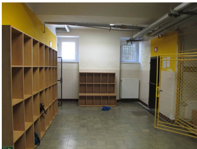
Foto č. 23 – v přístupové chodbě do šaten a sprch vystupují vlhkostní mapy nad úroveň keramických obkladů. Související příčinou je i úprava venkovních zpevněných ploch v úrovni 1.NP.
