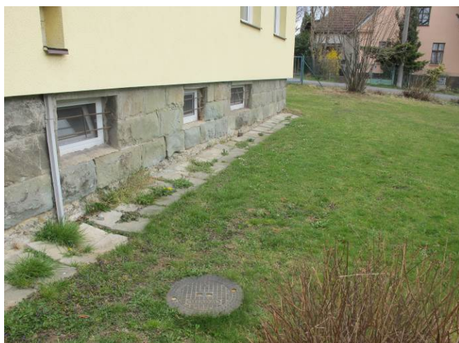
Foto č. 2 – vadné provedení okapového chodníku bez účinného odspádování a propadlou dlažbou z jižní strany
