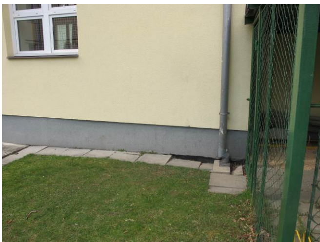
Foto č. 13 – nevhodná úprava dešťového svodu s propadlou dlažbou okapového chodníku u tělocvičny v návaznosti na přístřešek pro kola
