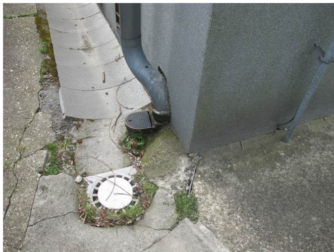
Foto č. 20 – nedořešený detail napojení na odvodňovací vpust
