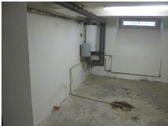
Foto č. 10 – vlhkostní mapa s výkvěty škodlivých stavebně rozpustných solí
