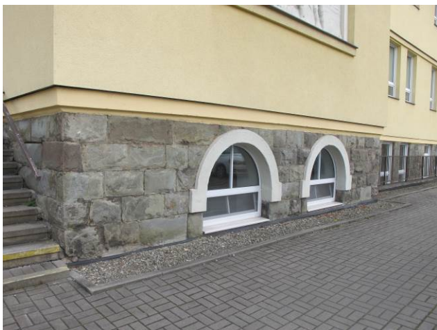
Foto č. 3 – drenážní úprava podél místnosti s hlavním uzávěrem vody (současný sklad)
